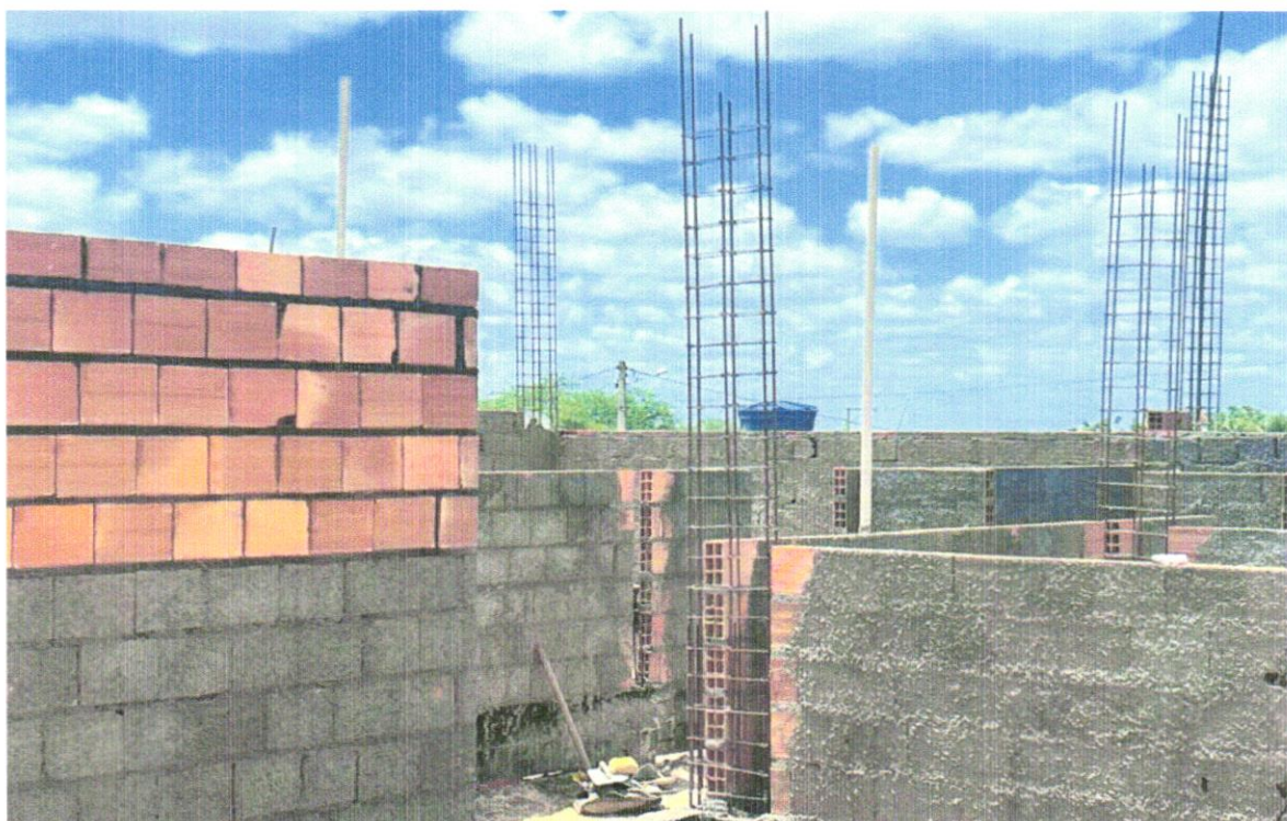
FOTO 06 – Armação de aço CA-50 Ø 10mm; incluso fornecimento, corte, dobra e colocação
