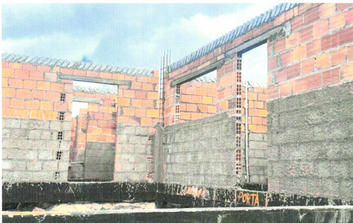
FOTO 24 – Verga e contraverga pré-moldada fck= 20MPa, seção 10x10cm
