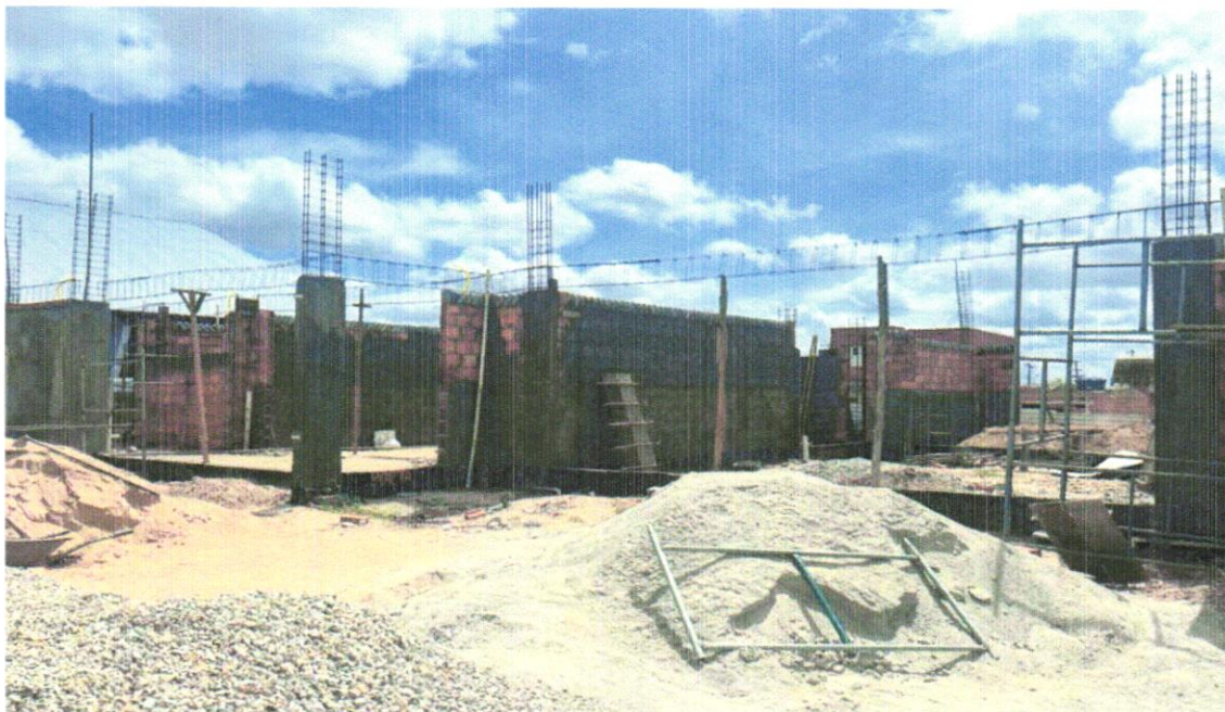
FOTO 18 - Armação de aço CA-50 Ø 10mm; incluso fornecimento, corte, dobra e colocação
