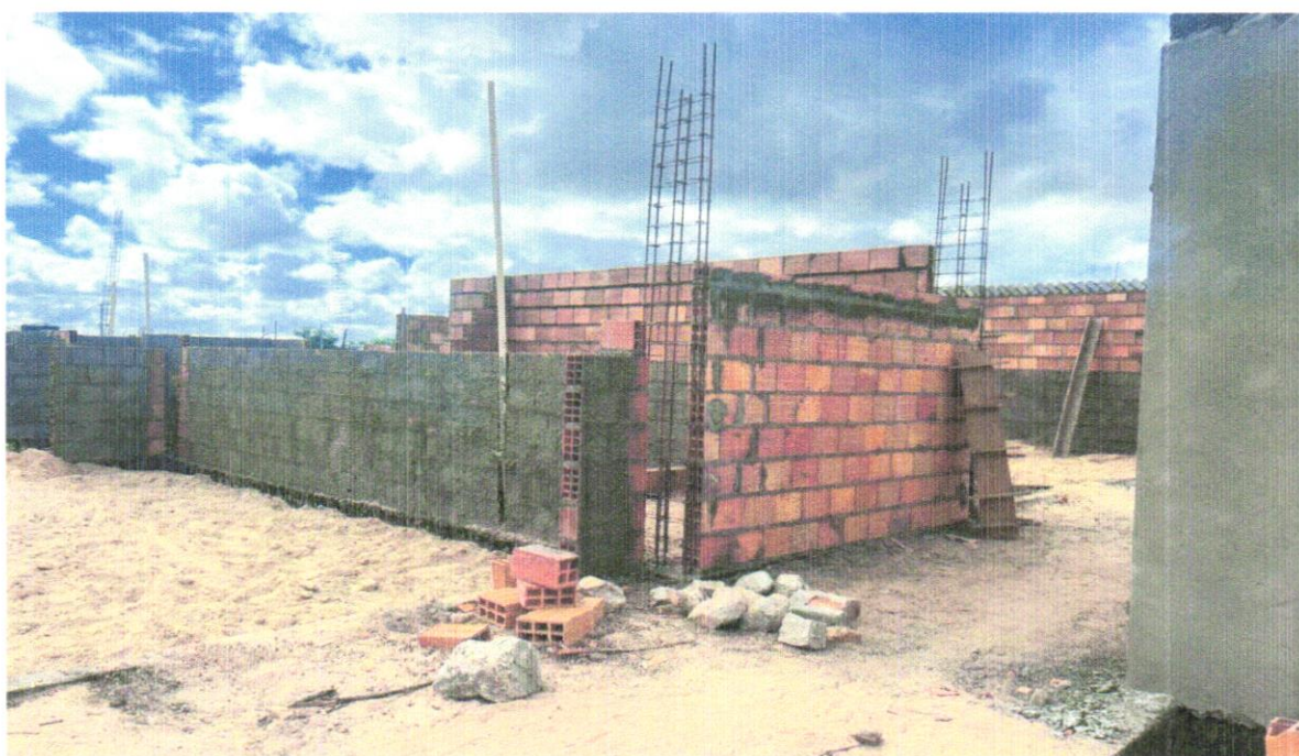
FOTO 10 – Armação de aço CA-60 Ø 5,0mm; incluso fornecimento, corte, dobra e colocação
