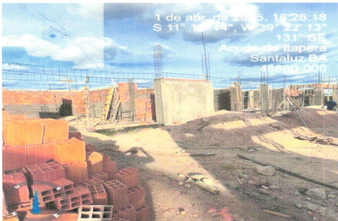
FOTO 18 - Armação de aço CA-50 Ø 10mm; incluso fornecimento, corte, dobra e colocação
