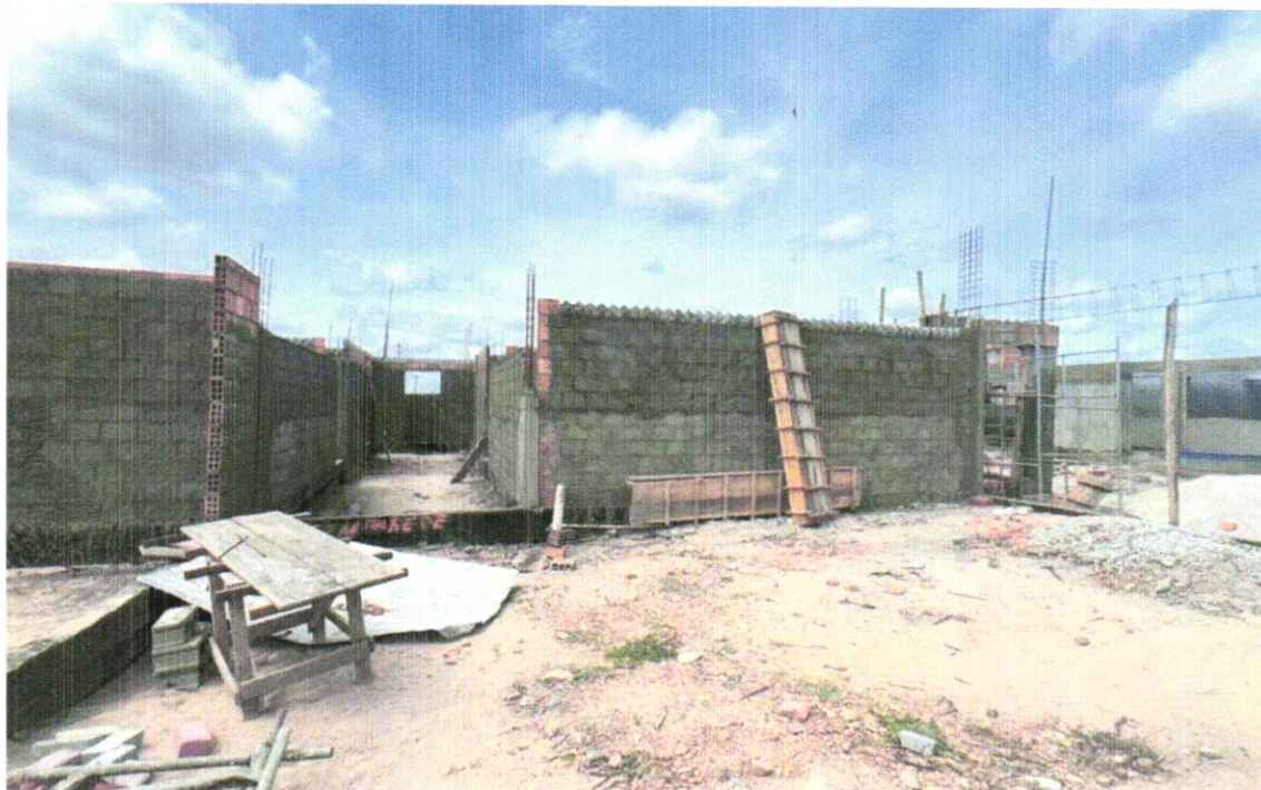
FOTO 44 – Chapisco de aderência em paredes internas, externas, vigas, platibanda e calhas
